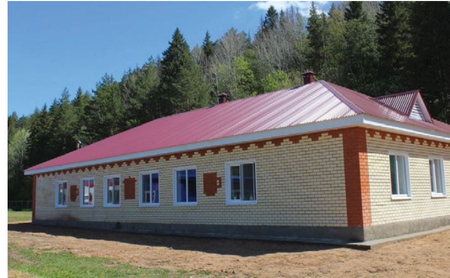
Капитальный ремонт столовой в детском оздоровительном лагере «Сосенка» Кукморского муниципального района
