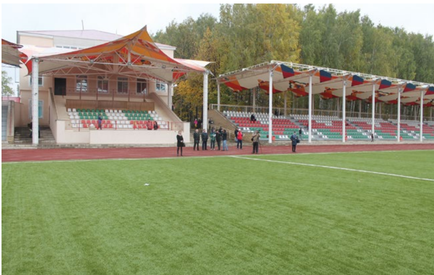
Реконструкция стадиона «Юбилейный» в г.Азнакаево Азнакаевского муниципального района
