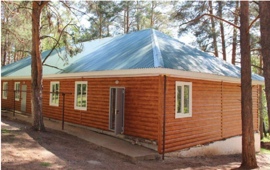
Капитальный ремонт двух спальных корпусов в стационарно-оздоровительном лагере «Лесная страна» Муслимовского муниципального района
