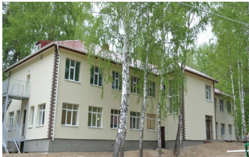
Реконструкция спального корпуса в детском оздоровительном лагере «Пламя» ГБУ «Республиканский центр по организации оздоровления, отдыха, занятости детей и подростков «Лето»
